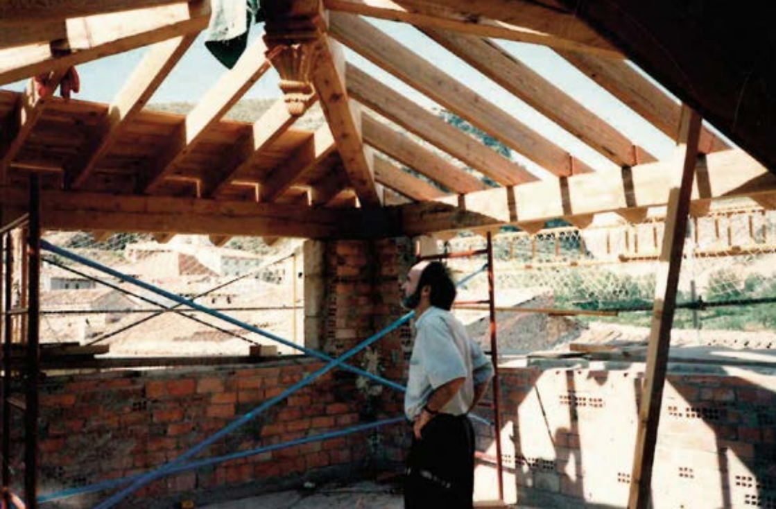
Figura 2. Mateo Andrés dentro del torreón que forma parte del ayuntamiento de Molinos en el transcurso de los trabajos de rehabilitación de la Escuela Taller de Molinos en 1992. Fuente: Archivo de Mateo Andrés
