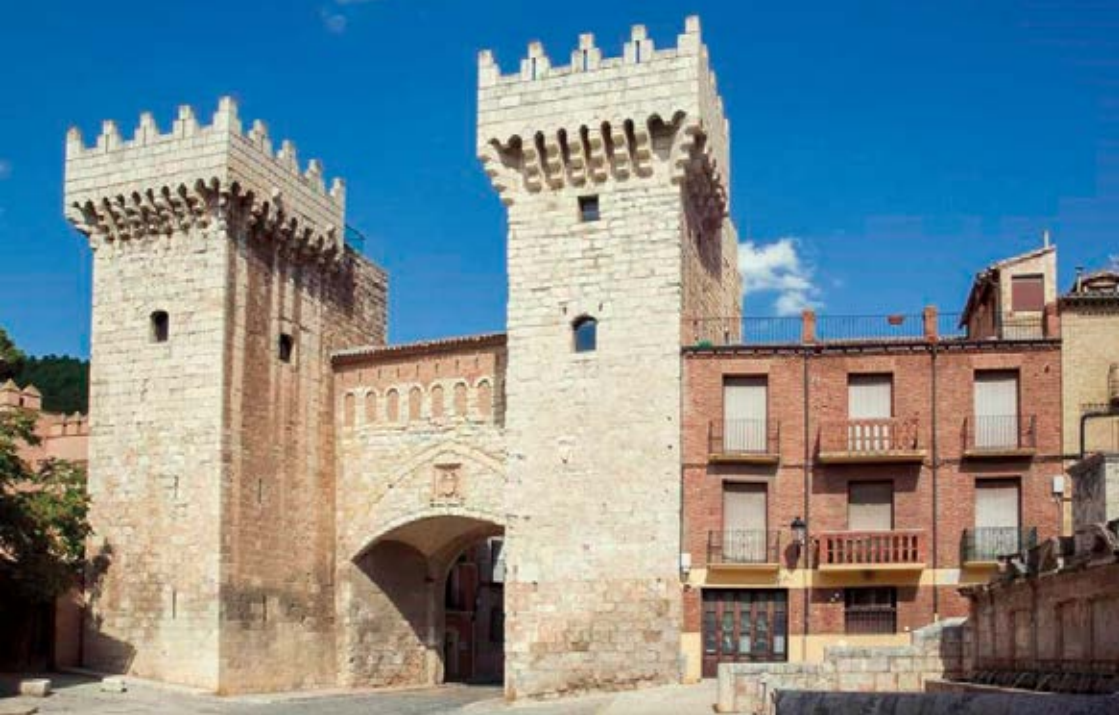
Figura 2. Puerta Baja de Daroca. Fuente: S. Sarfson
